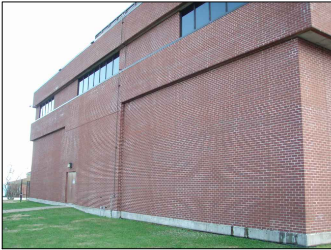
3 WTP NE WALL
